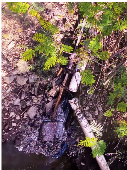
Esgoto in natura despejado em córrego dentro do município
