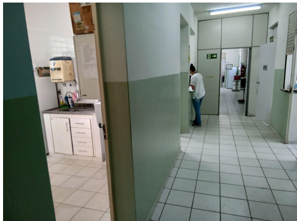
Cozinha na frente da passagem dos doentes
