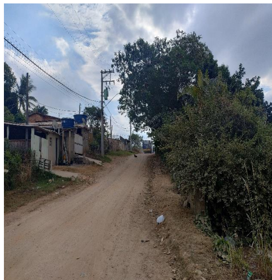
Foto 02 – Rua de terra (sem pavimentação ou tubulação de drenagem pluvial).
