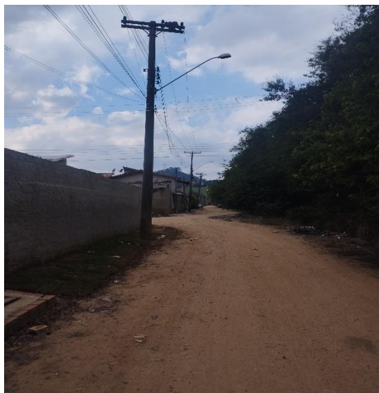
Foto 02 – Ruas sem asfaltamento.
