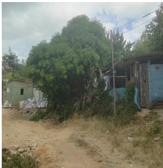
Foto 01 – Rua de terra (sem pavimentação ou tubulação de drenagem pluvial).
