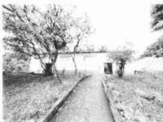
Foto N. 51 – Fachada do Prédio do Arquivo Geral e SAME.
