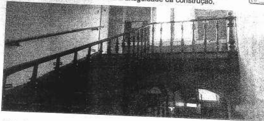
Antigo hall de entrada preservado.
