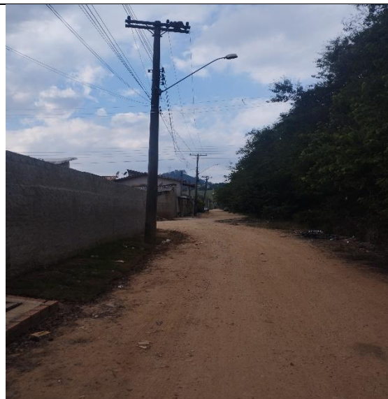
Foto 02 – Ruas sem asfaltamento.
