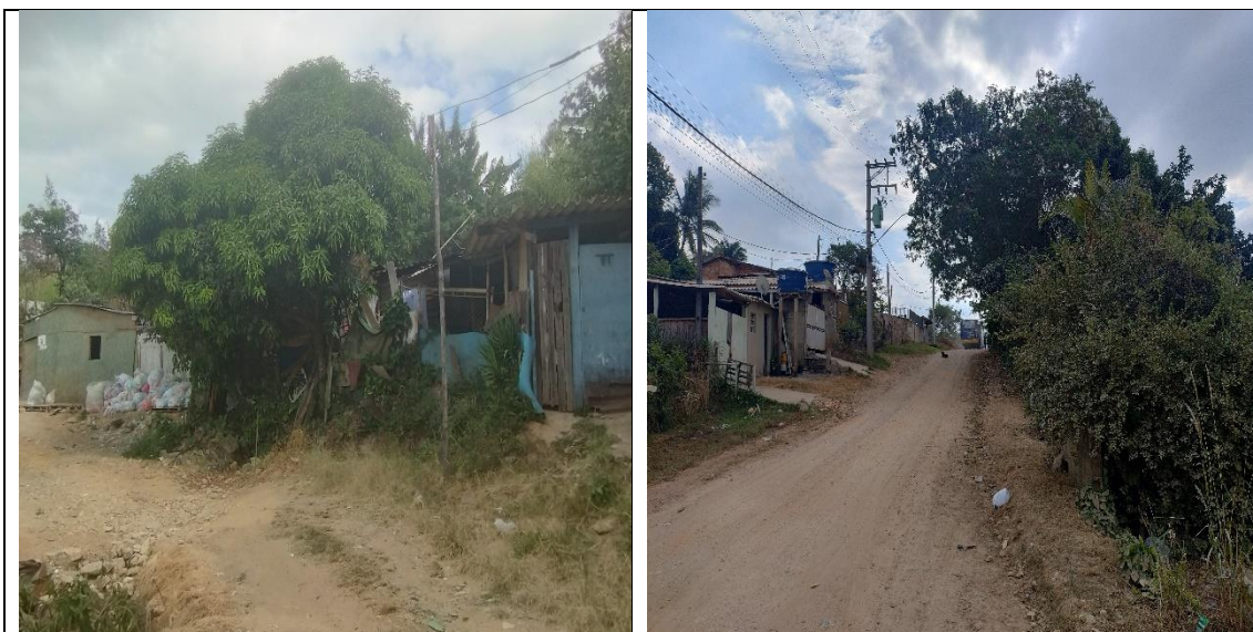
Foto 01 – Rua de terra (sem pavimentação ou tubulação de drenagem pluvial).
