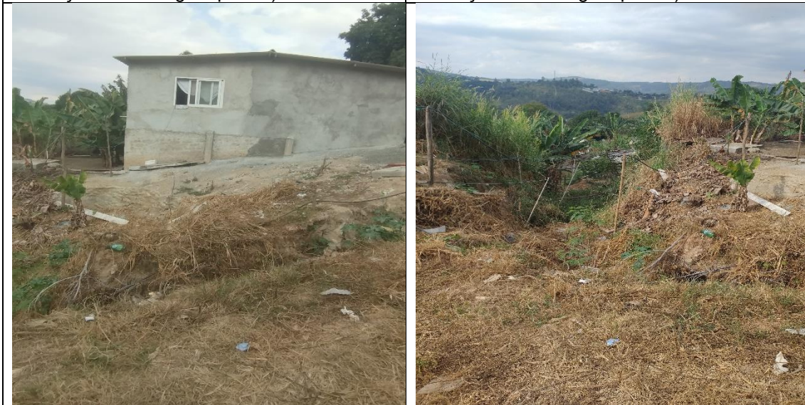
Foto 03 – Construções em áreas de risco.
