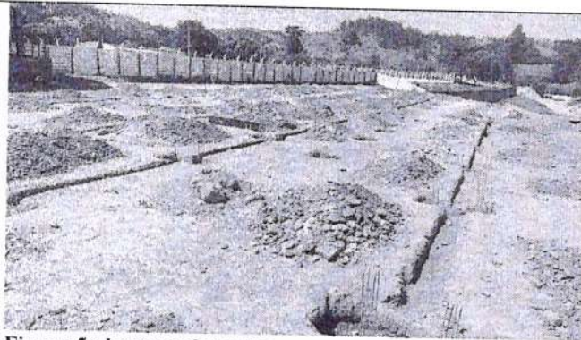
Figura 5 abertura das valas
