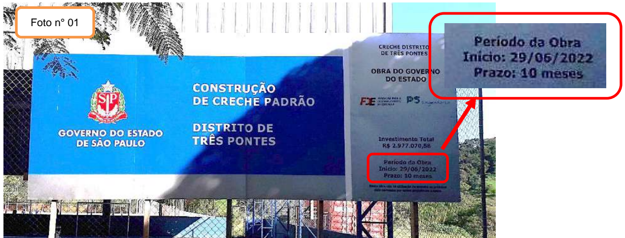
Foto n° 01 – Placa da Obra com previsão de início em 29/06/22.
