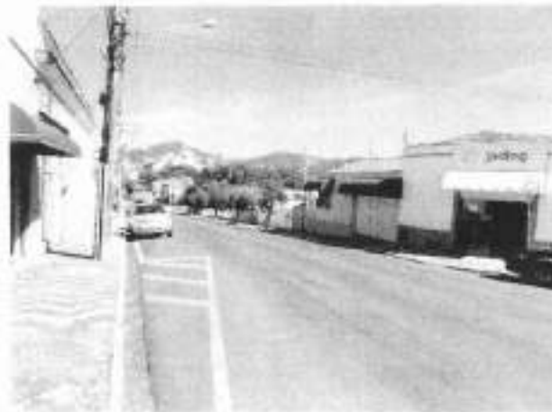
Fotos N. 02, 03 e 04 – Placa Indicativa e Vista da Rua Ana Cintra – Divisa entre os Bairros Jardim Primavera e São Judas, Município de Amparo -SP. Rua asfaltada, com guias e sarjetas, iluminação pública, rede de água, esgoto e telefonia.
