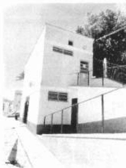
Fotos N. 61 e 62 - Vista Externa dos Sanitários Externos e Vestiário Feminino.
