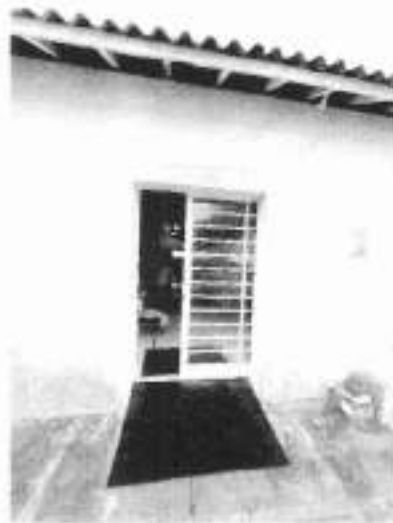
Fotos N. 43 e 44 - Vista do Prédio da Lavanderia e Farmácia.
