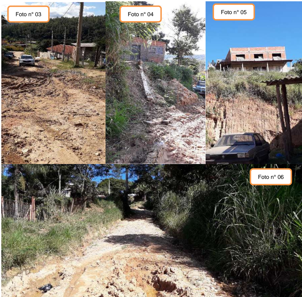
Fotos nº 01 a 06 - Planalto da Serra – Ausência de infraestrutura – ruas de terra (sem pavimentação ou tubulação de drenagem pluvial) em péssimas condições de trafegabilidade – construções em áreas de risco.
