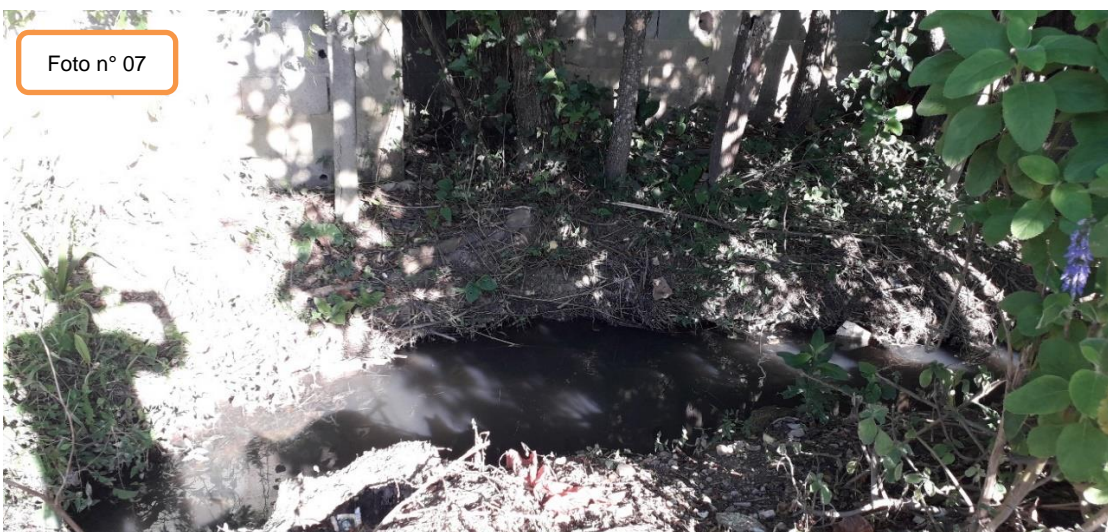
Fotos nº 05 a 07 – Bairro Jaguari – Ausência de infraestrutura – Esgoto à céu aberto – Descarte de entulhos e lixo em locais inapropriados.
