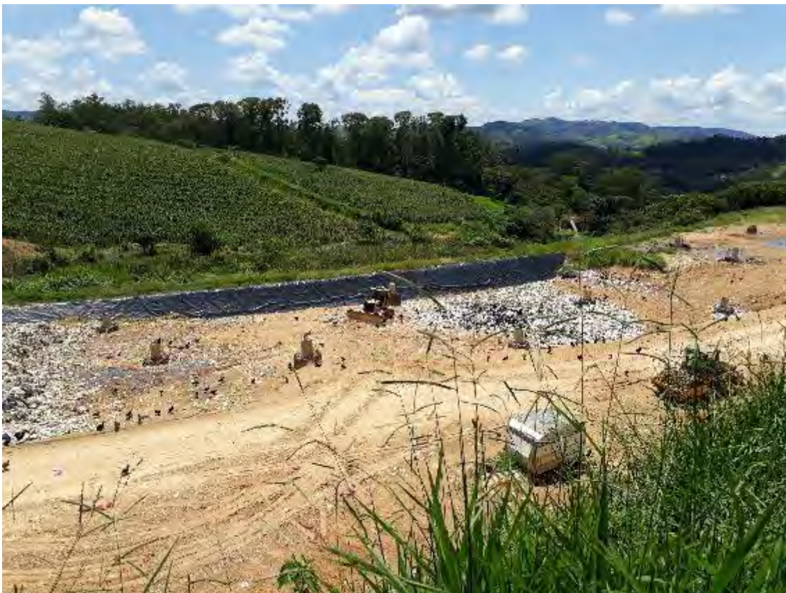
Foto 3 - Aterro Sanitário de Socorro.
