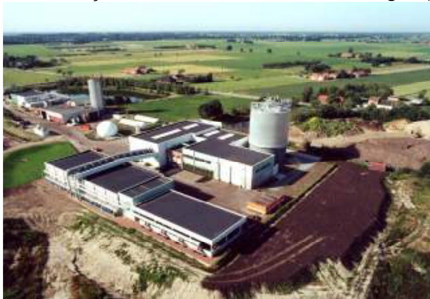
Figura 21 – Instalação TMB – Tratamento Mecânico Biológico (Bélgica)
