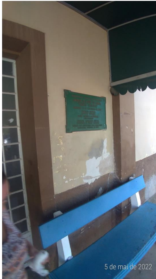
Foto 11 – Parede descascada.
