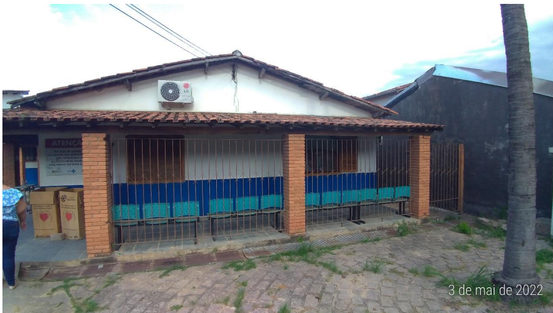
Foto 01 – Fachada da USF Pedrosos
