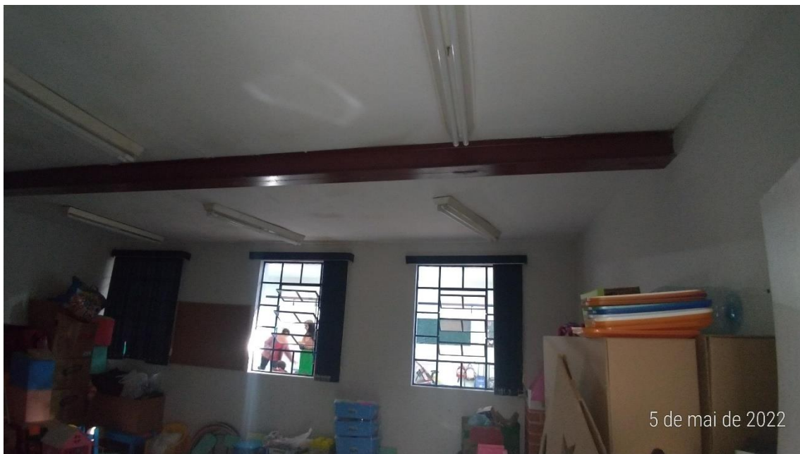
Foto 7 – Sala com uma espécie de escora em estrutura metálica.
