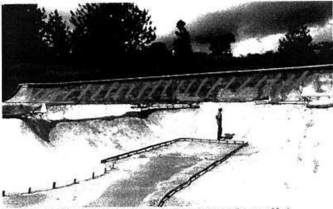
Imagem 1 Trecho vertical com 3,65m de altura cuja área compõe aprox 90m 2
