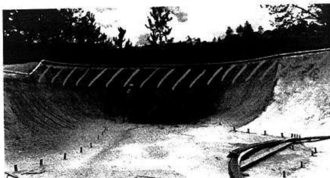
Imagem 5: Trecho vertical com 2,75m de altura
