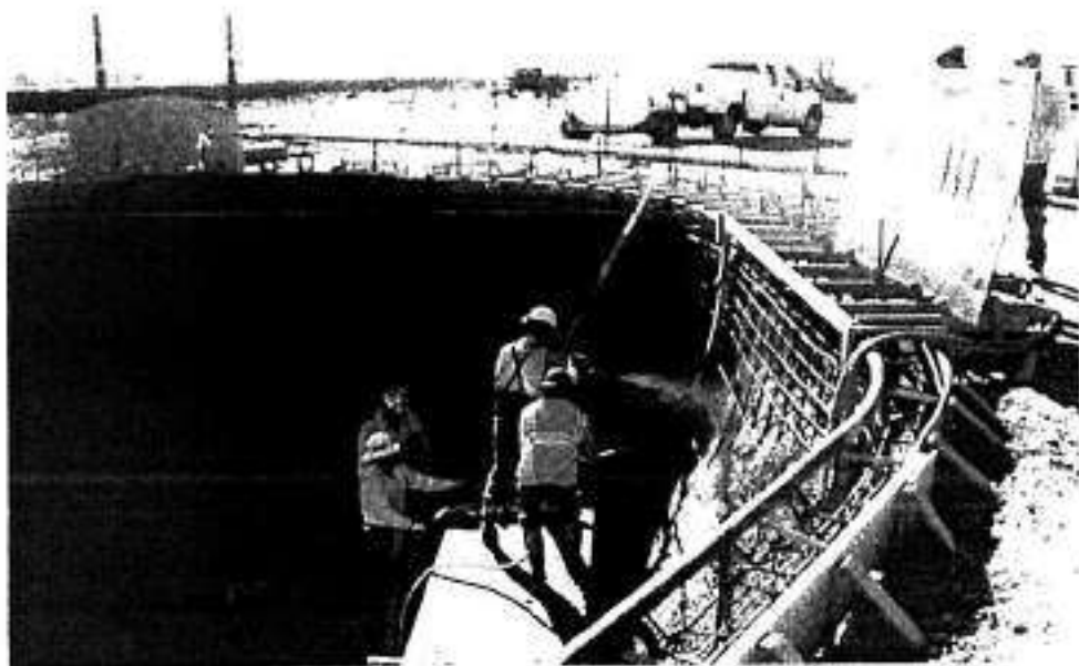
Imagem 6. Exemplo de profissionais projetando concreto em trechos Verticais.
