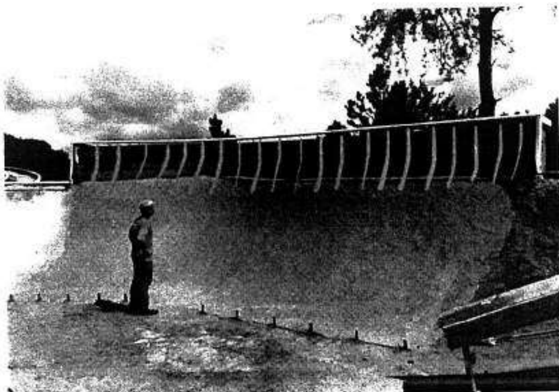
Imagem 3 Trecho vertical com 2,75m de altura.
