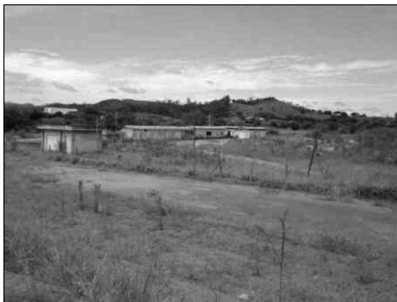
Figura 2.130 – Canteiro de Obra para Execução da ETE.
