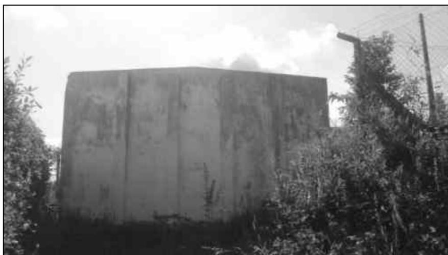
Figura 2.63 – Reservatório Jd. Nova Amparo (ETA II) – 200 m 3 - Estrutura de Alvenaria.
