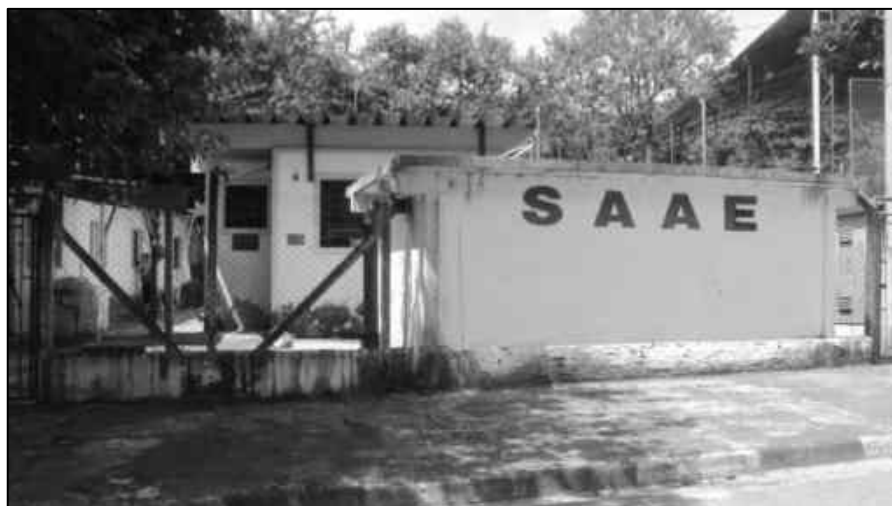
Figura 2.26 – Reservatório recalque “Moreirinha” (ETA I) – 30 m 3 - Estrutura Alvenaria.
