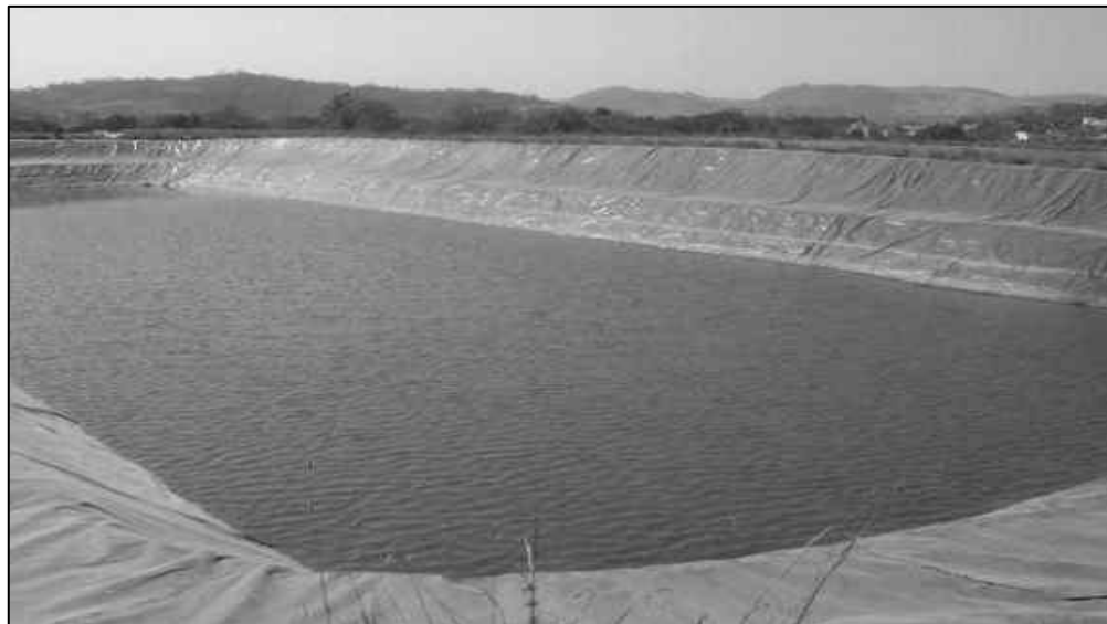
Figura 3.21 - Lagoa de tratamento de esgoto em fase de finalização
