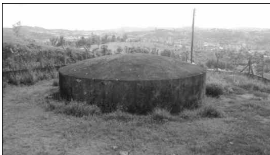
Figura 2.56 – Reservatório Jd. Brasil (ETA II) – 100 m 2 - Estrutura em Concreto
