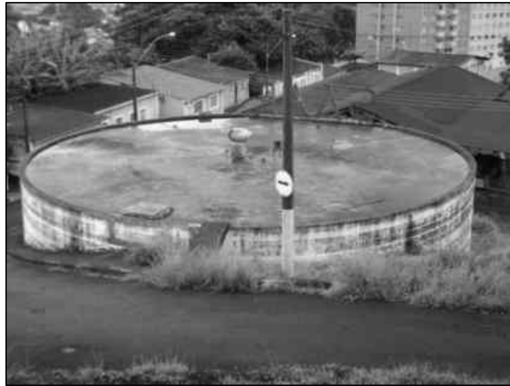
Figura 2.49 - Reservatório circular em concreto (ETA II) - 1500 m 3 - Localizado Na Rua Carlos de Campos.
