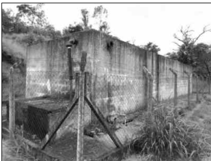
Figura 2.78 - Reservatório Silvestre IV (ETA II) - 300 m 3 - Estrutura de Alvenaria.
