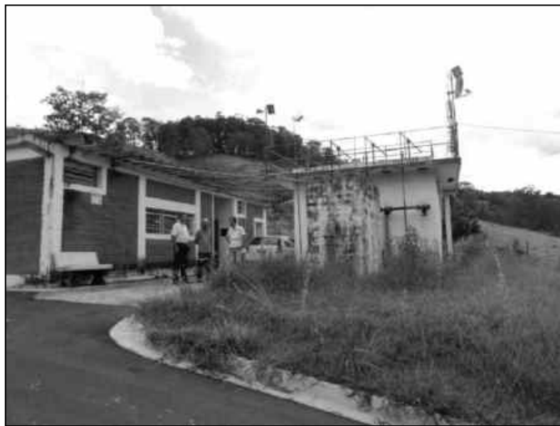
Figura 2.81 – Estação de Tratamento de Água do distrito de Três Pontes – ETA III.
