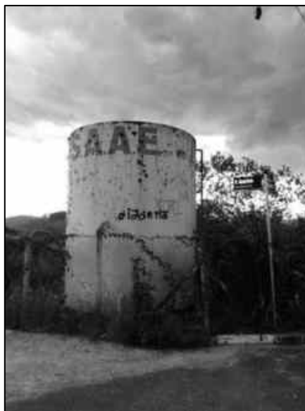
Figura 2.100 – Reservatório circular desativado (ETA III) - 30 m 3 - Estrutura Metálica.
