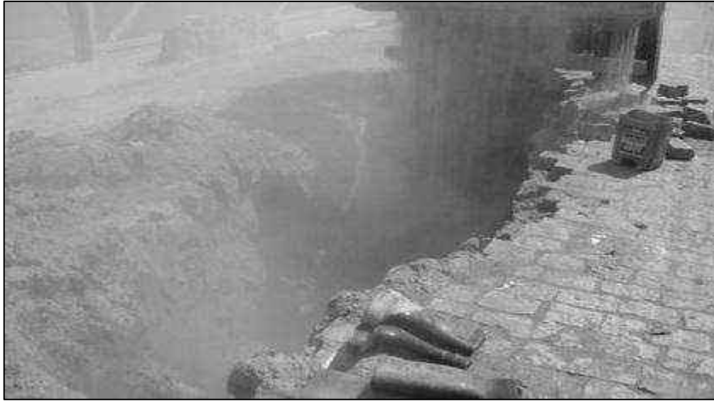
Figura 3.20 - Vala aberta para concerto de rede de água. Foto: Edson Fábio Machado/AT
