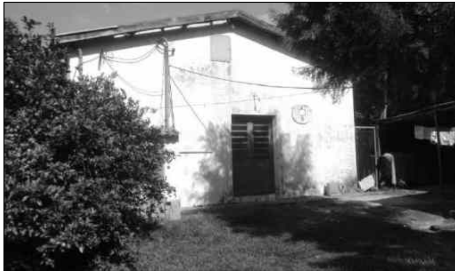
Figura 2.65 – Estação de recalque Pinheirinho – ETA II.
