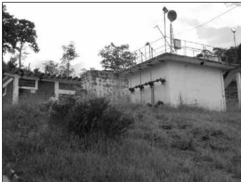
Figura 2.84 – Estação de tratamento de água compacta em concreto armado.
