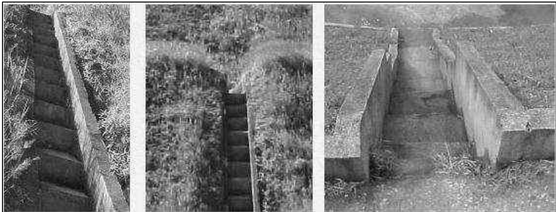
Figura 10.1 – Estruturas para redução de energia do Fluxo do Efluente Tratado.
