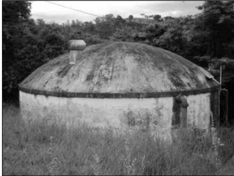
Figura 2.94 - Reservatório apoiado – Circular (ETA III) - 280 m 3 - Estrutura de Concreto.
