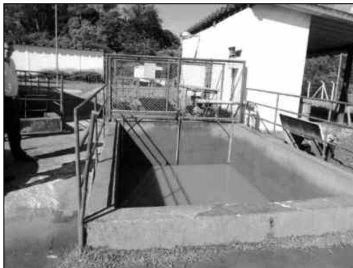
Figura 2.4 - Poço de chegada de água bruta segmentado pelo gradeamento.
