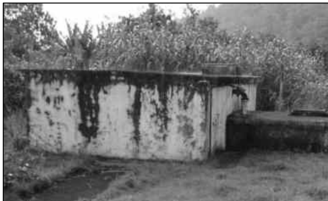
Figura 2.99 - Reservatório apoiado, Serra das Estâncias (ETA III) - Estrutura de Concreto.
