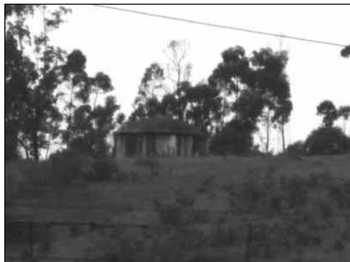
Figura 2.51 - Reservatório Circular, Canavial (ETAII) - 400 m 3 - Estrutura de Concreto.
