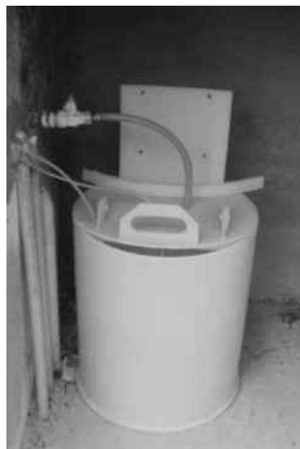
Figura 2.128 – Recipiente para Solução de Cloro – Estância Seabra.
