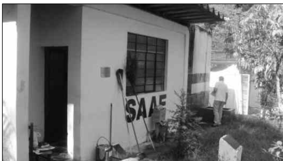
Figura 2.57 - Reservatório de recalque, Jd. Nova Amparo (ETA II) – 30 m 3 - Estrutura de concreto.
