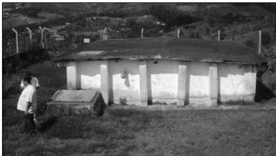
Figura 2.55 – Reservatório Jd. Brasil (ETA II) – 200 m 3 - Estrutura de Concreto.
