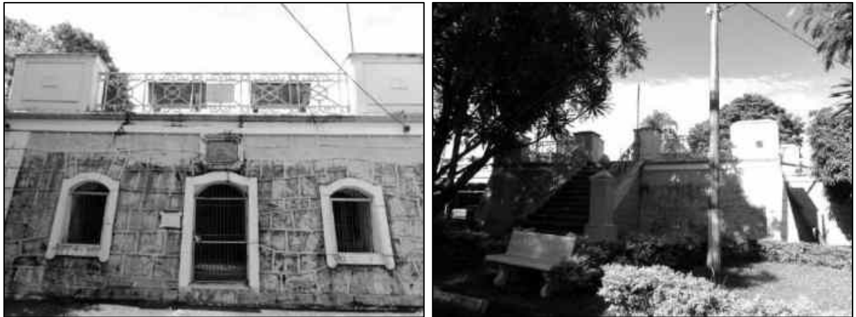
Figura 2.21 - Reservatório R1 - Semi-enterrado - 900 m 3 - ETA I - Parque Dr. Arruda.
