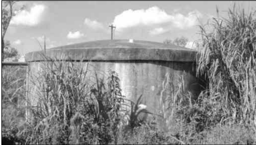
Figura 2.70 – Reservatório Jd. Pinheirinho (ETA II) – 170 m 3 - Estrutura de Concreto.
