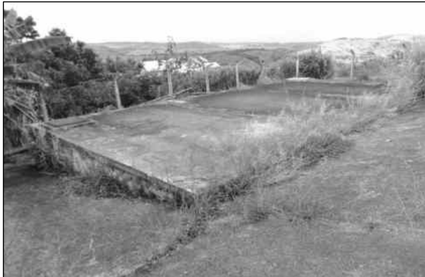
Figura 2.24 - Reservatório Flamboyant (ETA I) - 100 m 3 .
