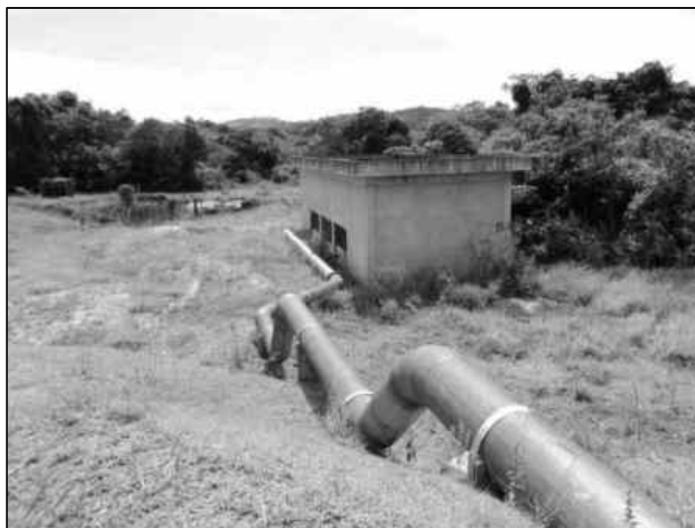
Figura 2.132 – Saída de Tubulação da Casa dos Aeradores.
