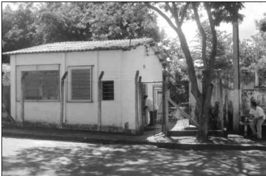
Figura 2.52 – Reservatório de Recalque, Jd. Brasil (ETA II) – 30 m 3 - Estrutura em Alvenaria.
