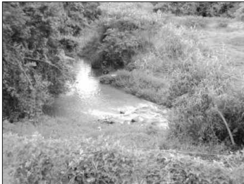
Figura 2.109 - Ponto de Descarte do Lodo da ETA IV - Córrego Mosquito.
