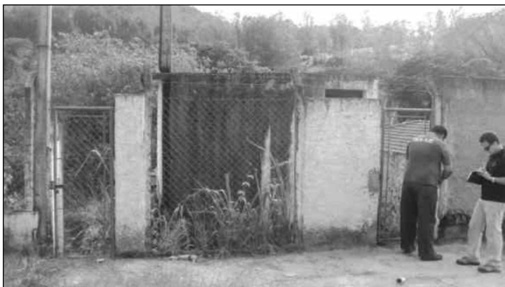
Figura 2.123 – Estação de Recalque e Poço Artesiano – Jd. Beira Rio.
