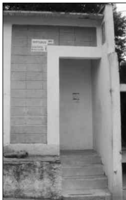
Figura 3.6 - Entrada vestiário masculino.
