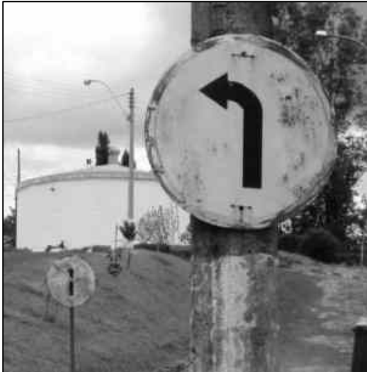
Figura 3.10 - Sinalização vertical em decomposição
