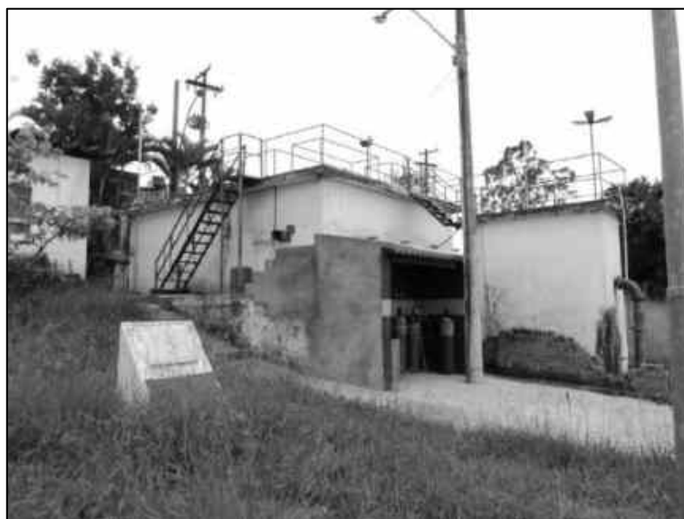
Figura 2.102 – Unidade componente do sistema de tratamento de água da ETA IV – Distrito Arcadas.
