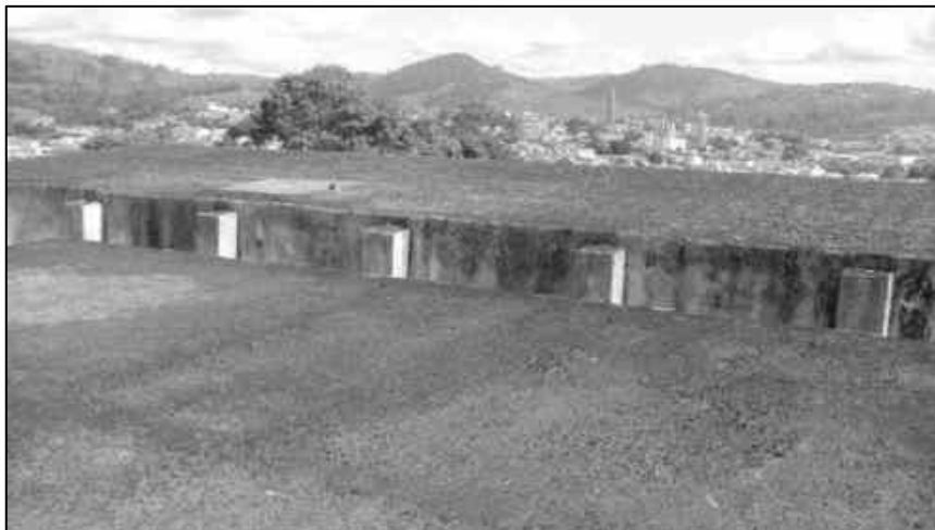
Figura 2.61 – Reservatórios Jd. Nova Amparo (ETA II) – 50 e 200 m 3 - Estrutura de Concreto.
