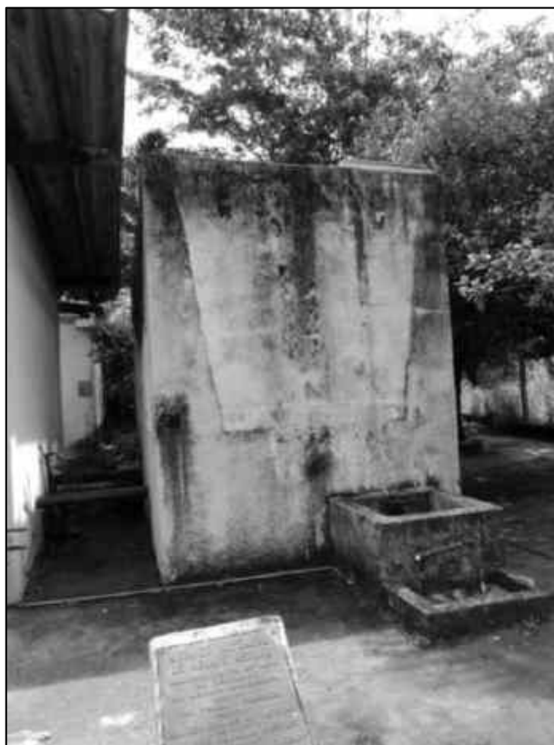
Figura 2.27 – Reservatório de recalque Moreirinha (ETA I) – 20 m 3 – Estrutura de Alvenaria.
