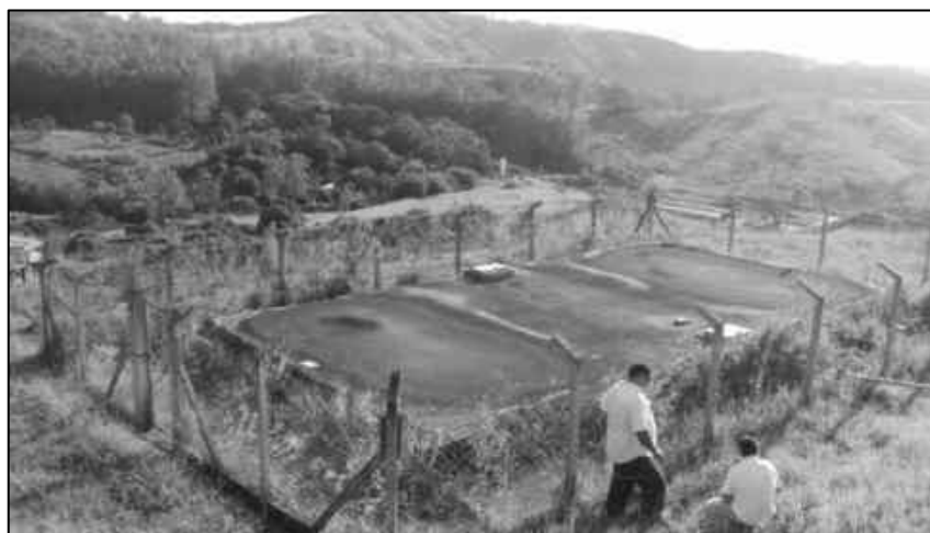
Figura 2.25 – Reservatório “Zé Felício” Jd. Flamboyant (ETA I) – 100 m 3 - Estrutura Alvenaria
