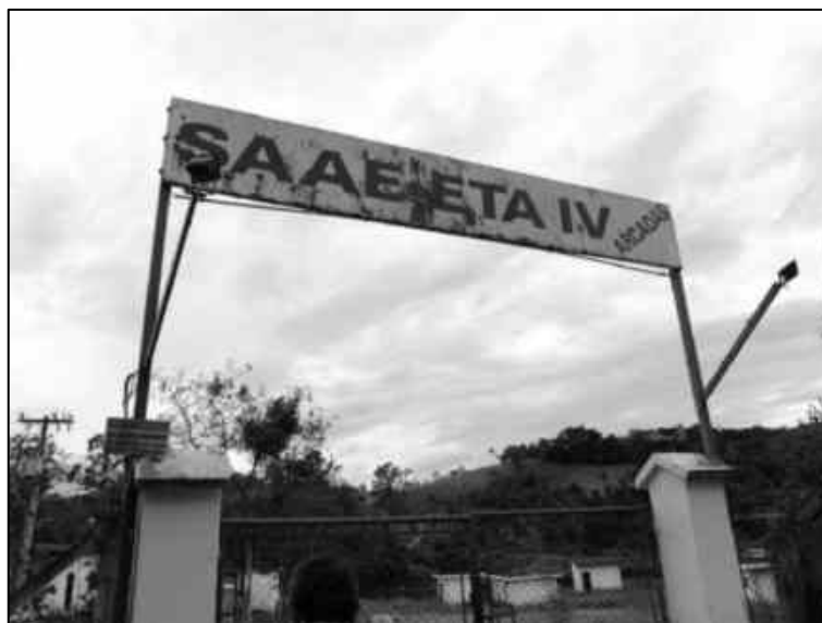
Figura 2.101 – Entrada da Estação de Tratamento de Água do distrito de Arcadas – ETA IV.
