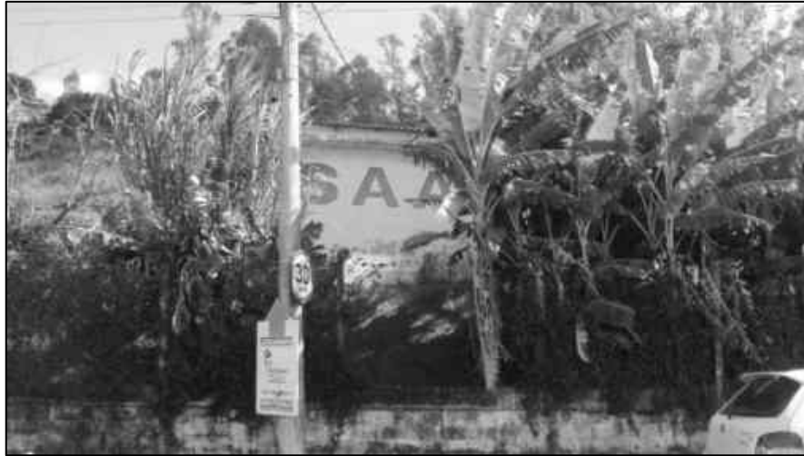
Figura 2.64 - Reservatório de Recalque Pinheirinho (ETA II) – 30 m 3 – Estrutura de Alvenaria.
