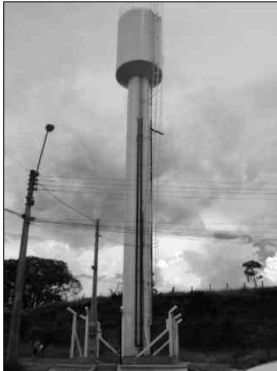
Figura 2.79 – Reservatório elevado Parque Modelo (ETA II), Rua Souto Oliveira – 20 m 3 - Estrutura Metálica.
