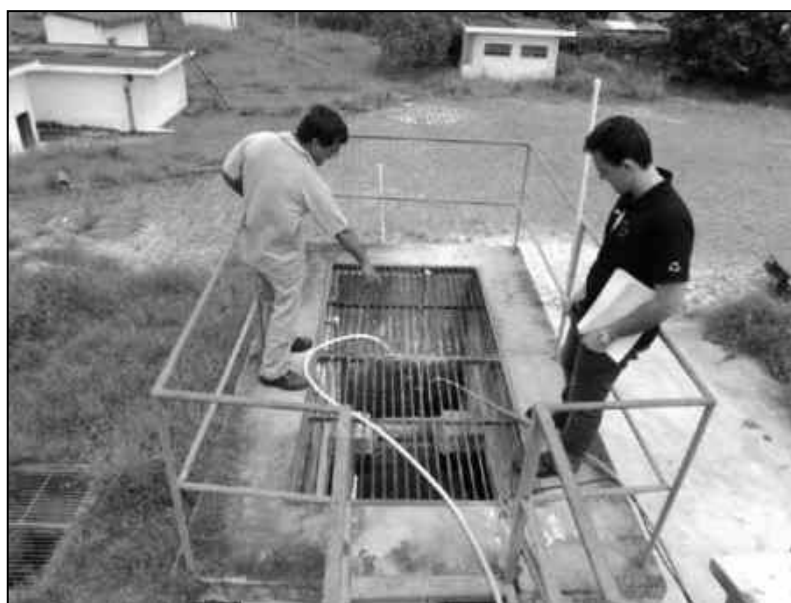
Figura 2.110 - Ponto de correção do pH através da adição da cal.
