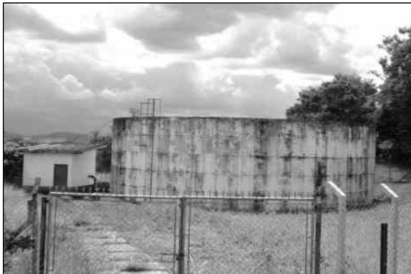
Figura 2.41 – Reservatório Figueira (ETA I) – 800 m 3 - Estrutura de Concreto.
