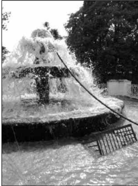
Figura 2.16 – Estrutura de gradeamento e captação de água bruta para análise – ETA I - Parque Dr. Arruda.
