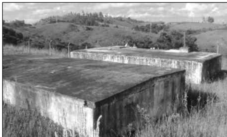
Figura 2.75 – Reservatórios semi-enterrados Jd. Silmara (ETA II) – 200 e 100 m 3 - Estrutura em Alvenaria.
