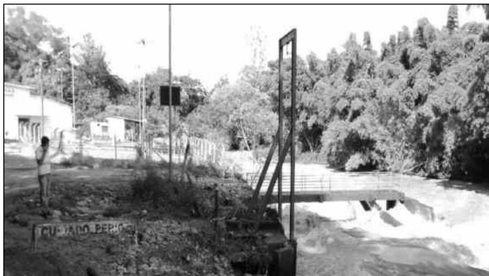
Figura 3.2 - Captação próxima e pouca diferença de nível com rio.
