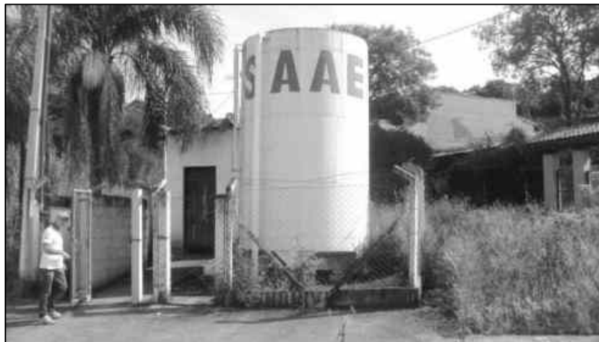
Figura 2.95 – Reservatório de recalque - circular metálico - (ETA III) - 30 m 3 - Estrutura Metálica.
