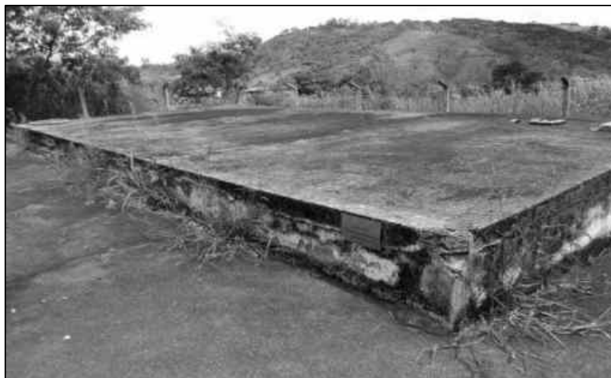
Figura 2.31 – Reservatório Flamboyant (ETA I), Rua Santa Bárbara – 100 m 3 - Estrutura de Alvenaria.
