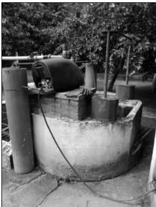
Figura 2.134 - Poço de chegada do Efluente Bruto – ETE localizada em Arcadas.
