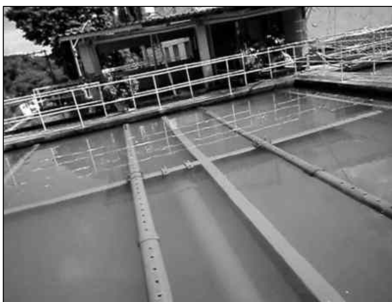
Figura 2.18 - Tubulações de distribuição e captação da Água - ETA I - Parque Dr. Arruda.
