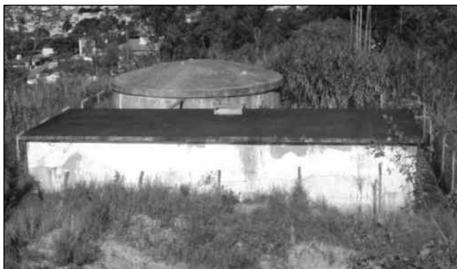
Figura 2.69 – Reservatórios interligados no Jd. Pinheirinho - ETA II.
