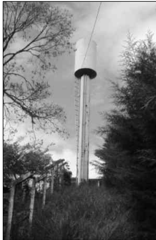
Figura 2.125 – Reservatório Metálico – 46 m 3 - Beira Rio.
