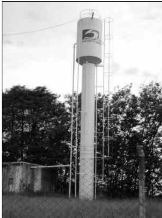
Figura 2.119 - Reservatório da Fazenda do Túnel.
