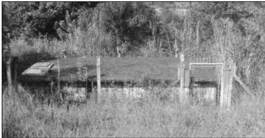
Figura 2.97 - Reservatório Semi-enterrado, Serra das Estâncias – “de baixo” (ETA III) – 80 m 3 - Estrutura de Concreto.
