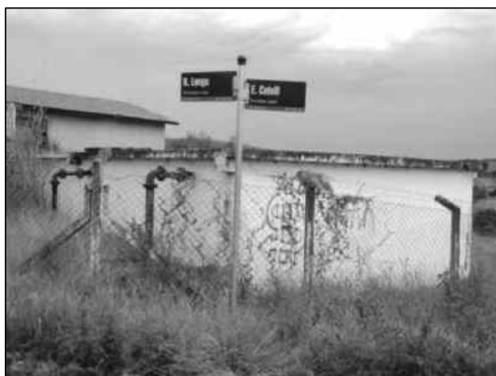
Figura 2.77 - Reservatório Silvestre IV (ETA II) - 170 m 3 - Estrutura de Alvenaria.
