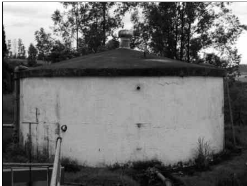
Figura 2.48 - Reservatório circular em concreto (ETA II) - 400 m 3 - Localizado na Rua Carlos de Campos.
