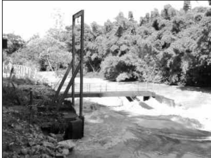
Figura 2.3 - Ponto de captação do Rio Camanducaia.
