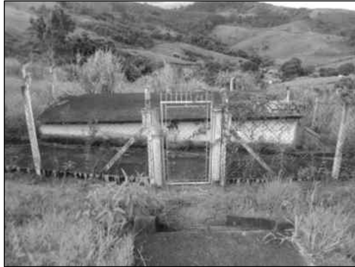
Figura 2.96 – Reservatório Semi-enterrado, Serra das Estâncias – “do meio” (ETA III) – 80 m 3 - Estrutura de Concreto.
