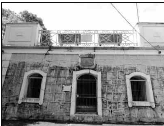
Figura 2.14 - Reservatório construído no início do Séc. XX – ETA I.
