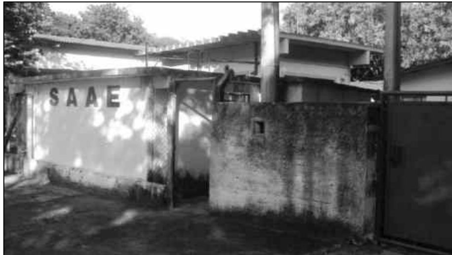
Figura 2.32 - Estação de recalque Jd. Figueira (ETA I) – Reservatório em Alvenaria – 30 m 3 .
