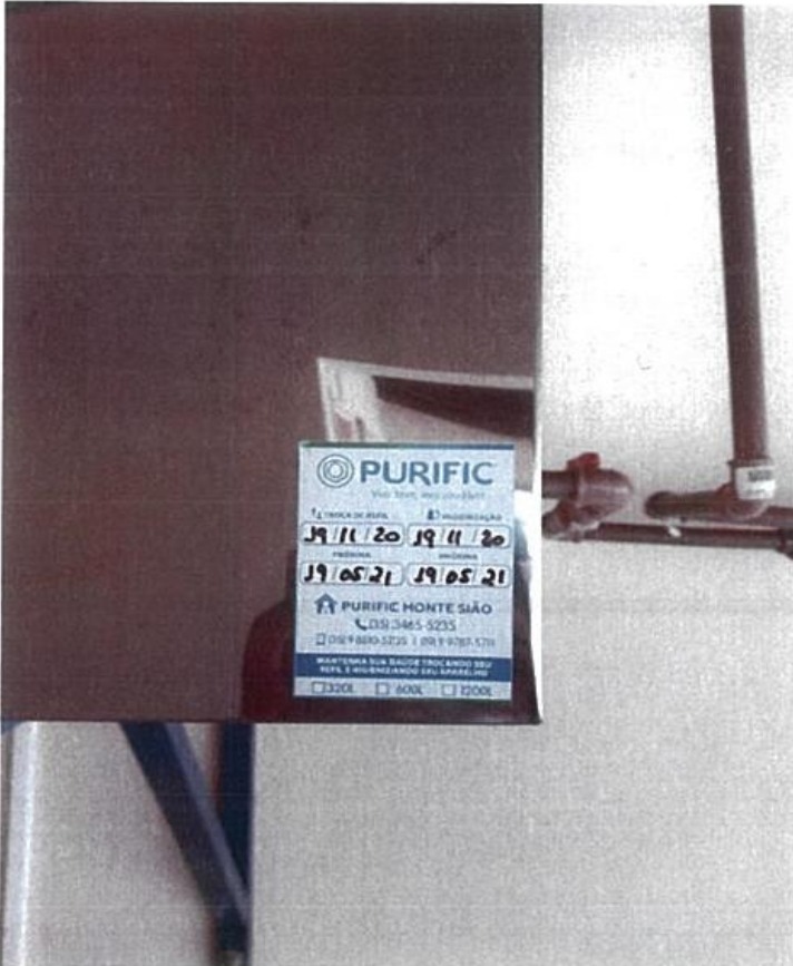
Foto 01 - Filtro trocado, conforme descrito ao item E. do presente documento.
