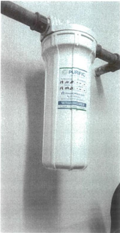
Foto 02 - Filtro trocado, conforme descrito ao item D. do presente documento.
