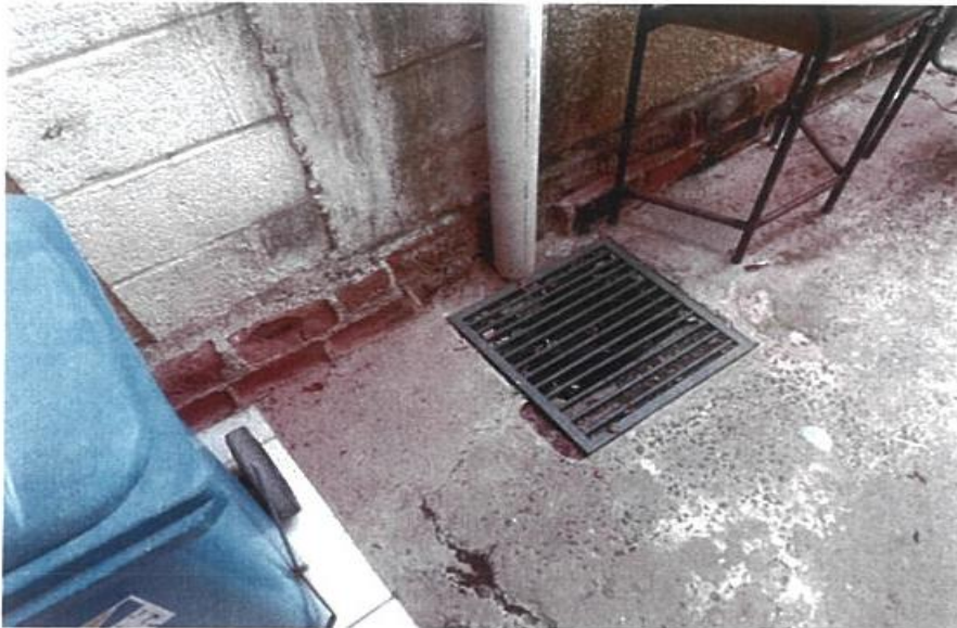
Foto 03 - Ralo trocado, conforme descrito ao item J. do presente documento.
