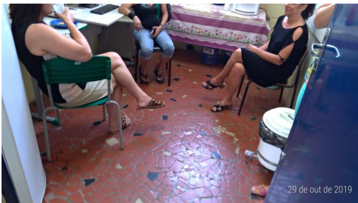
Foto 20 – Sala dos professores em tamanho inadequado.
