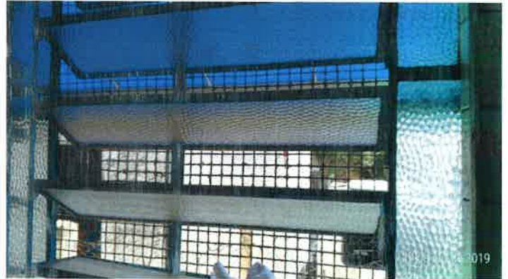
Foto 04 – Janela da cozinha com tela antiferretada de proteção contra insetos.
