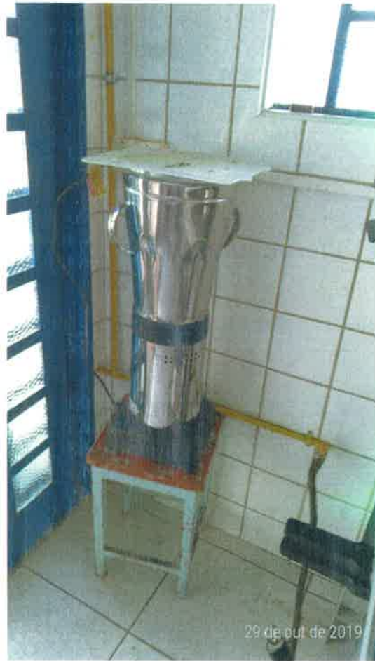
Foto 10 – Uso de equipamentos em local inapropriado.
