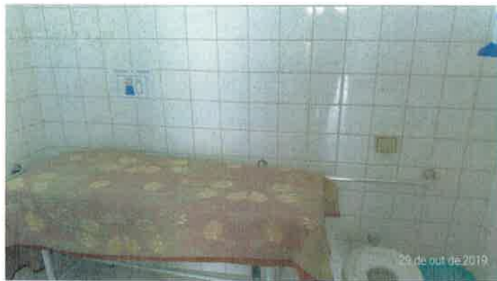
Foto 30 - Trocador infantil coberto por tecido permeável, instalado no banheiro de uso comum dos alunos.
