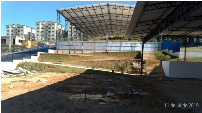
Foto 02 – Uma das entradas da escola, com quadra poliesportiva ao fundo. Ainda há entulhos e tapumes no local.
