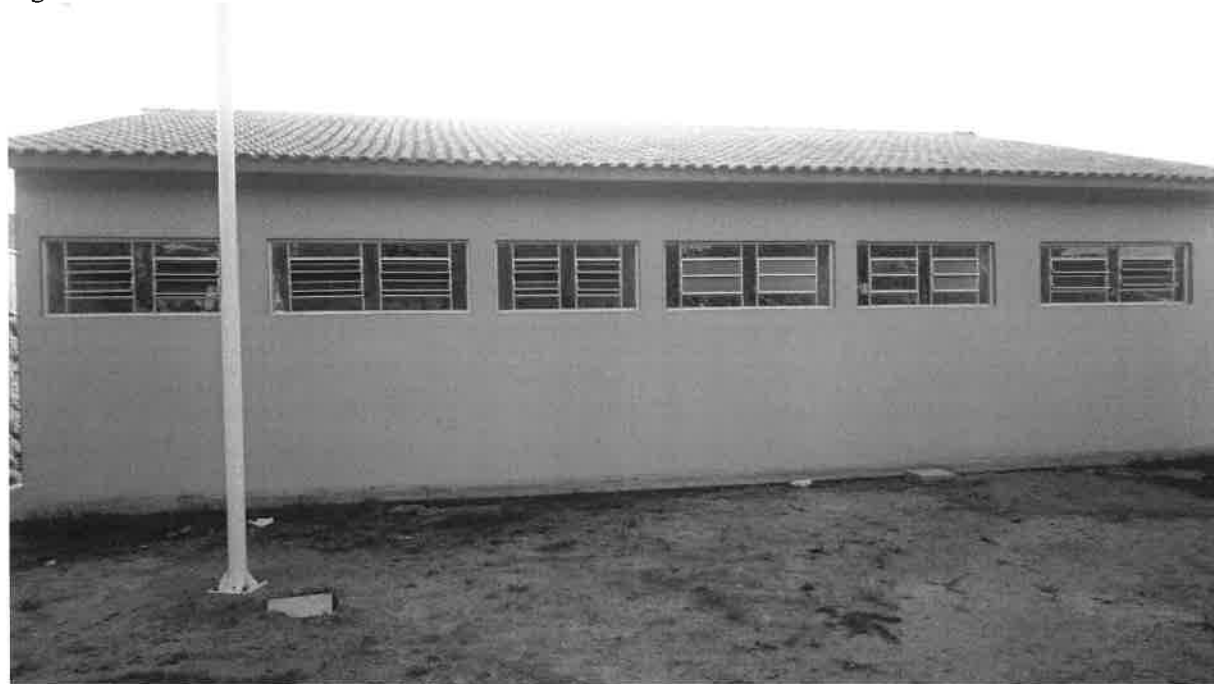
Figura 2 Vista da fachada dos fundos do vestiário
