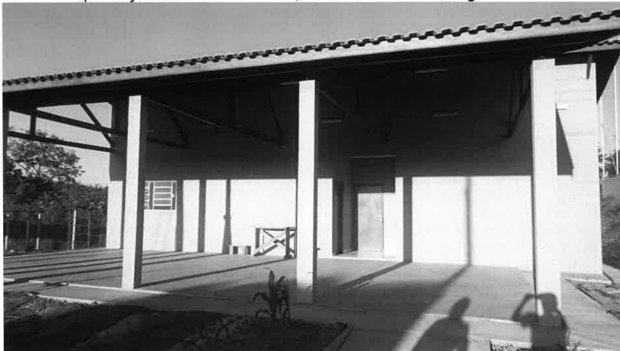
Figura 1 vista da fachada frontal do vestiário
